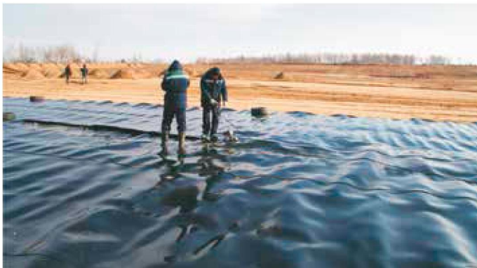
Укладка геомембраны на 1 ой секции полигона
