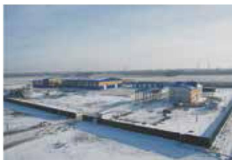
Общий вид площадки МПС «Северная».
